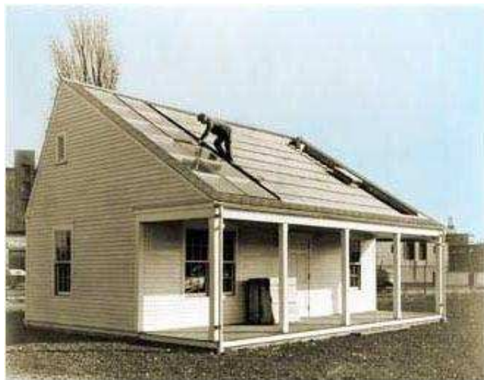
Figura 7 Instalación de placas fotovoltaicas en la rehabilitación de una cubierta
